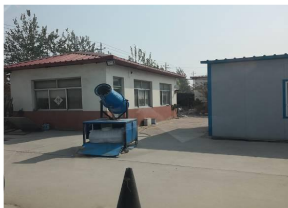
施工期喷雾作业
