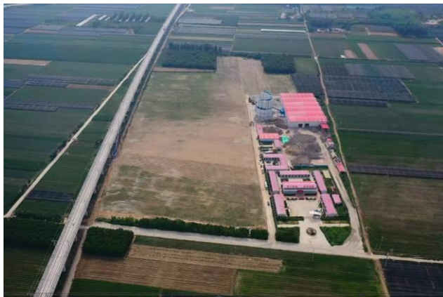
图 6.9-2 昌邑南制梁场（大部分已复垦，拌合站和驻地已移交）
