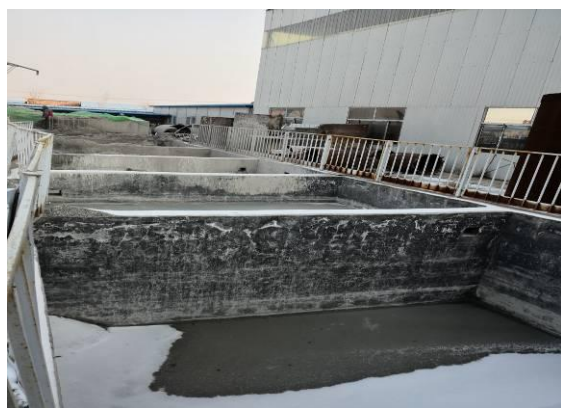
2 标拌合站三级沉淀池
