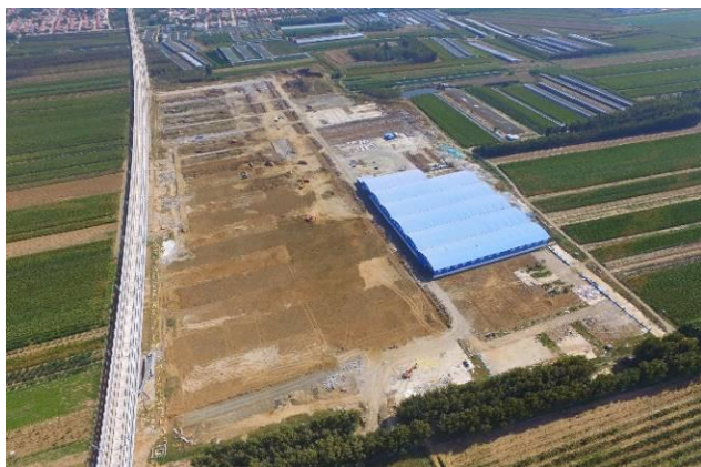
图 6.9-5 平度东制梁场（正在拆除）
