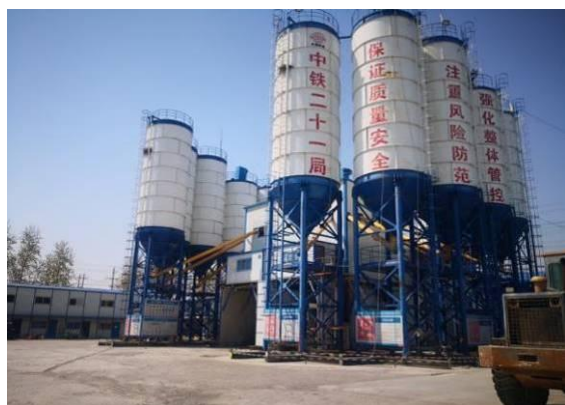
拌合站密筒仓+除尘器
