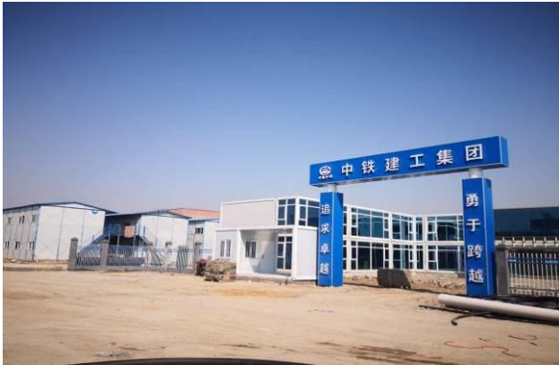
图 6.9-8 1 标 1#拌合站（已移交中铁建工集团使用）
