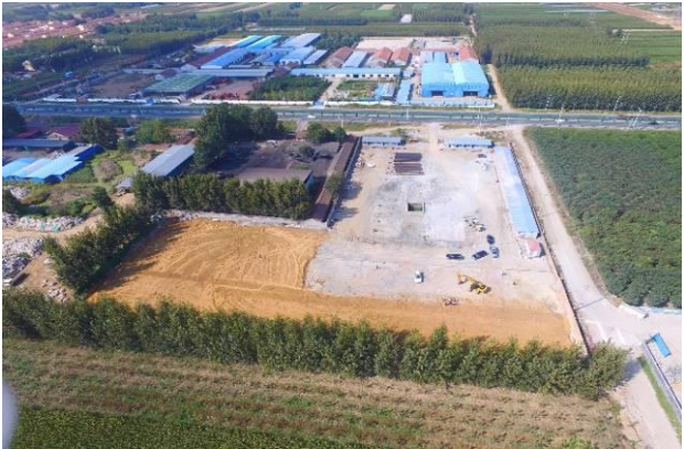
图 6.9-9 1 标 2#拌合站（耕地已复垦，厂房已移交）
