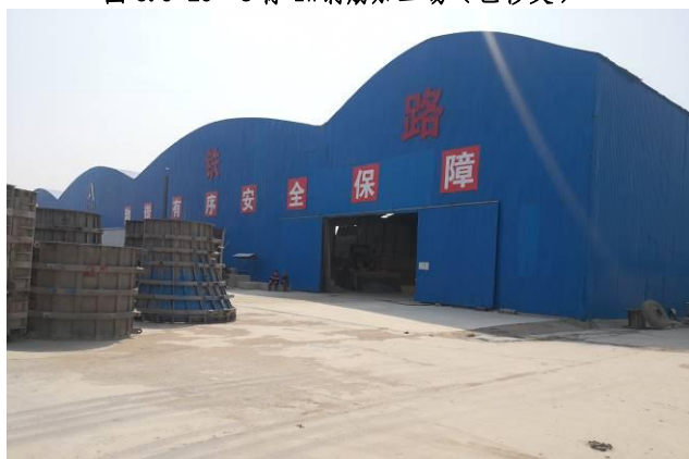
图 6.9-31 4 标 9#钢筋加工场（未复垦）
