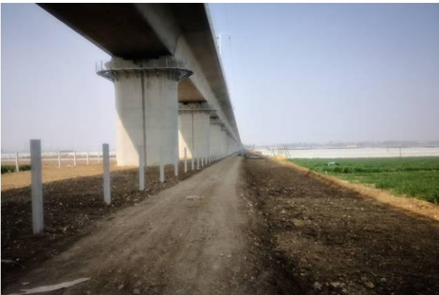
图 6.9-33 已复垦施工便道
