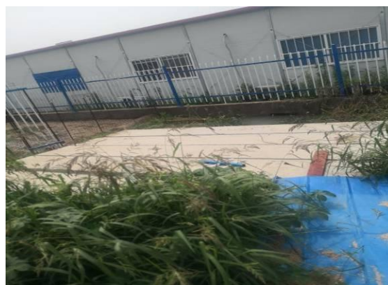
施工驻地生活污水化粪池处理
