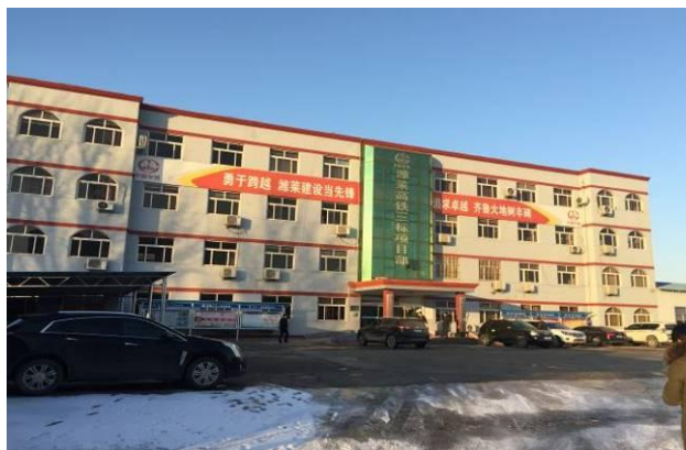
图 6.9-22 3 标项目驻地（正在使用）
