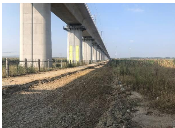
图 6.9-34 已复垦施工便道
