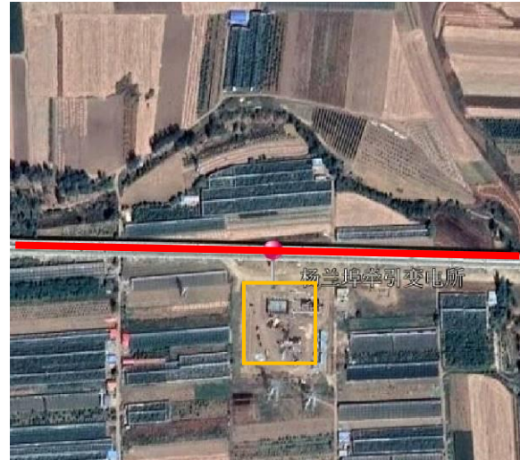
杨兰埠牵引变电所
