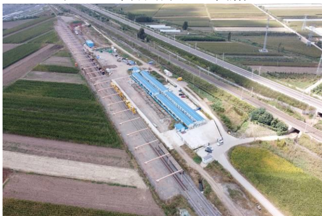
图 6.9-7 铺轨基地（正在拆除）
