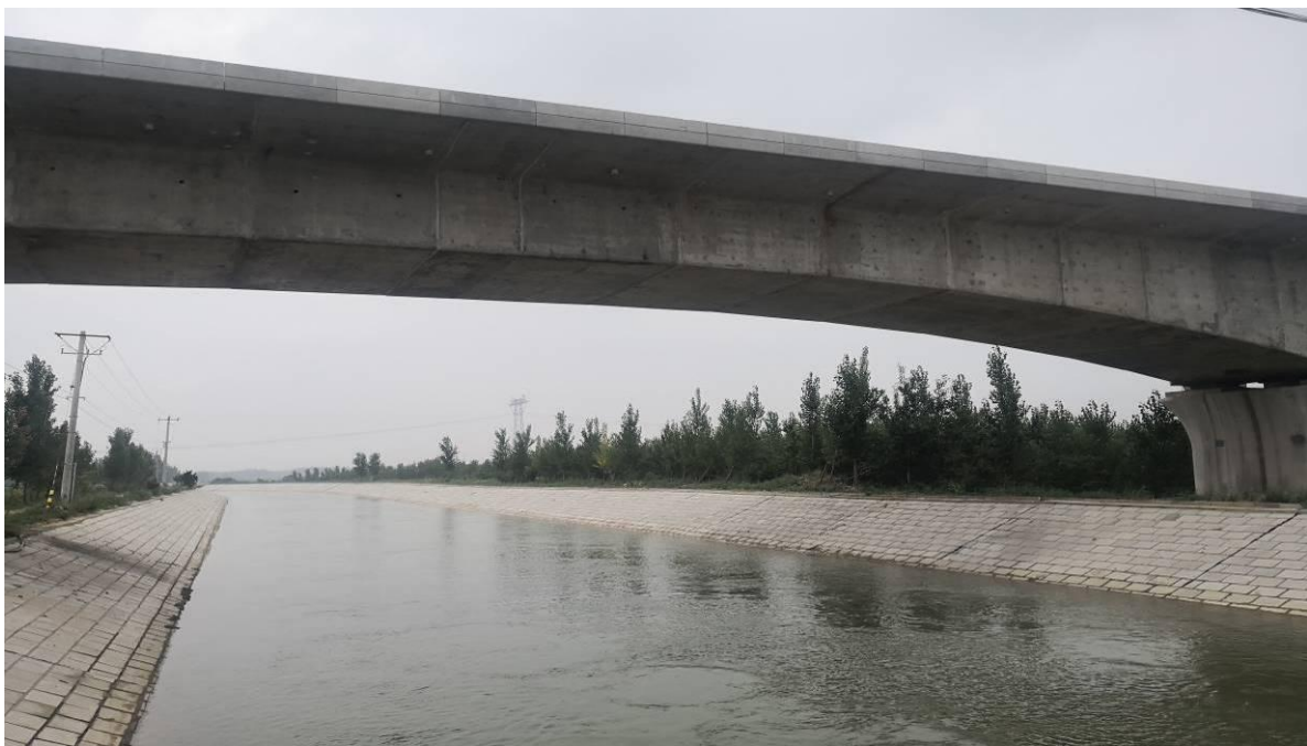
图 9.2-7 工程与引黄济青饮用水干渠相对位置关系、现状照片
