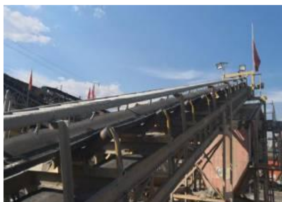
石料运输传送带采取自动喷淋降尘措施
