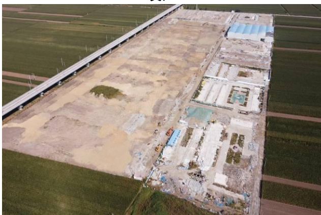
图 6.9-4 平度制梁场（正在拆除）
