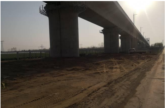
图 6.9-32 已复垦施工便道
