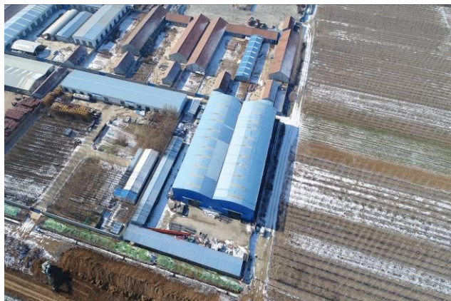
图 6.9-27 1 标项目部钢筋加工场（已移交）
